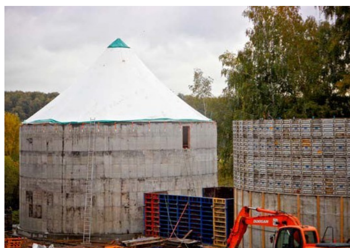
Установка крыши шатрового типа
