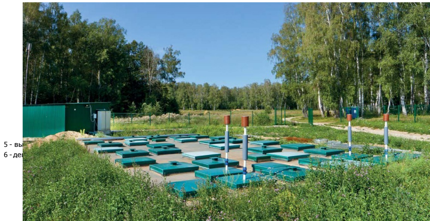
Завершение монтажа "ЕВРОБИОН-БИОМАТРИКС"
