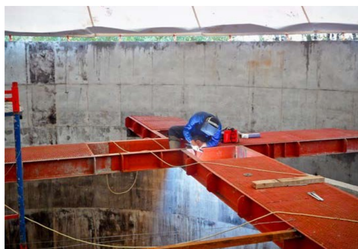
Монтаж эксплуатационных проходов
