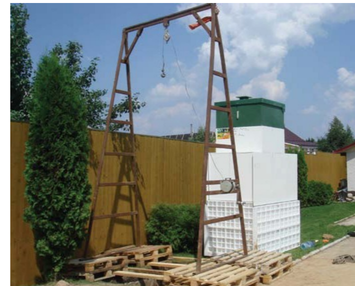
Монтаж станции ЮБАС в земляную выемку
