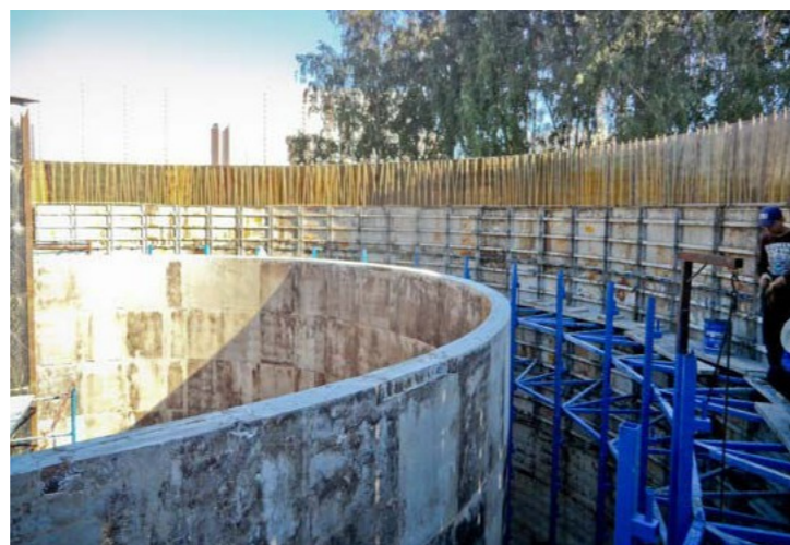
Формирование кольцевого аэротенка зональной аэрации
