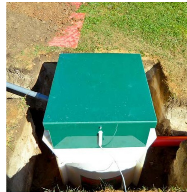
Установка станции в котлован
