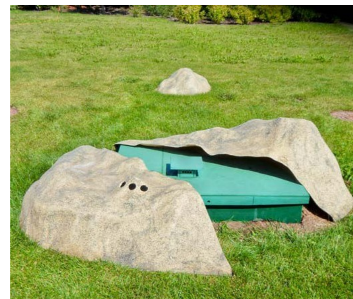
Установка ЮБАС после проведения ландшафтных работ
