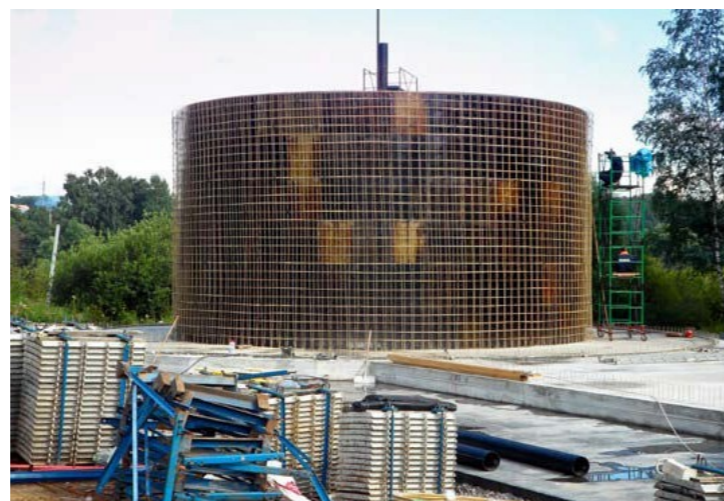
Сборка опалубки
