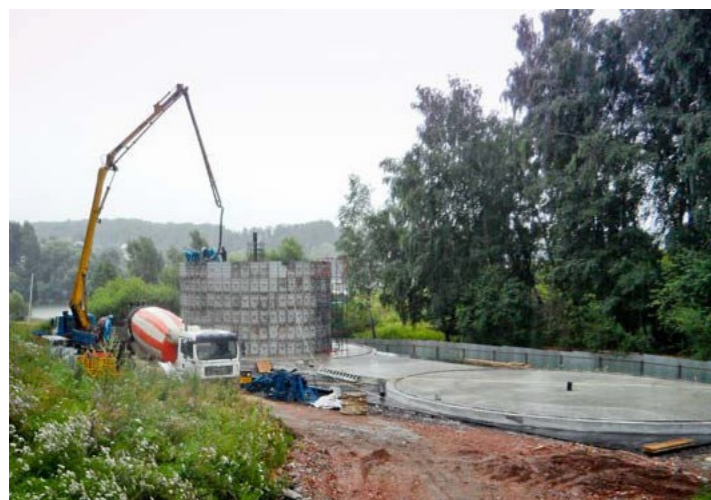
Заливка первого резервуара
